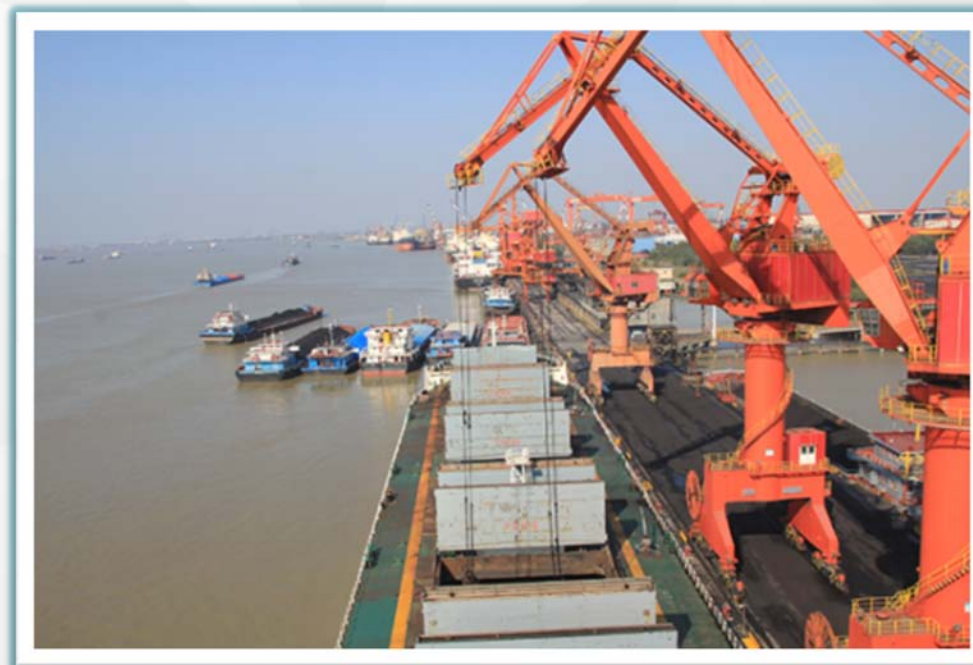
新增门机投入使用
