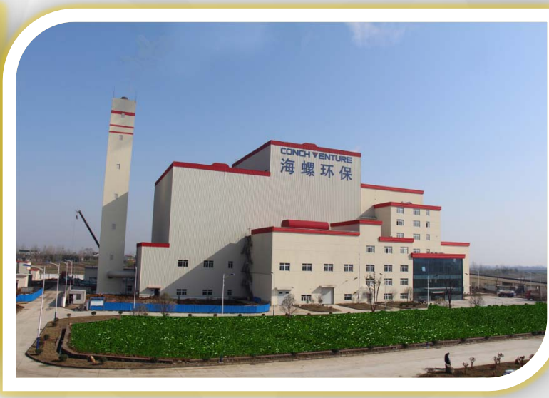
霍邱炉排炉项目投产运行
